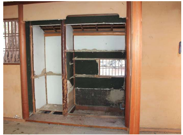
図7 水屋(解体が進んでいる)
