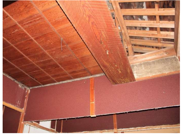
図 9 六畳の天井(解体が進んでいる)
