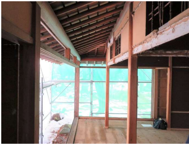
図6 北面縁廻り(解体が進んでいる)
